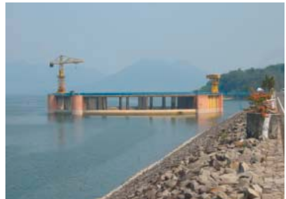
写真： チタラム川、Jatiluhur ダムの巨大な取水口。
